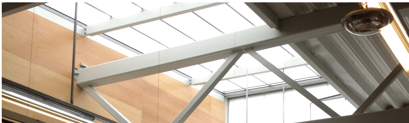
Rema 1000 store at Kroppanmarka with 220m 2 translucent aerogel panels. Photo: Anne G.Lien | Rema 1000 butikk i Kroppanmarka med 220 m 2 translusente polykarbonatplater fylt med aerogel. Foto: Anne G.Lien
